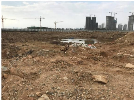
照片 4：场地现状及西周边在建工程
