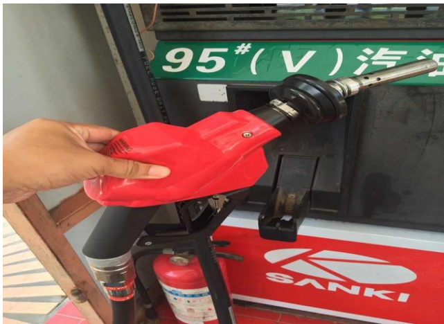
照片 6 带油气回收功能加油枪
