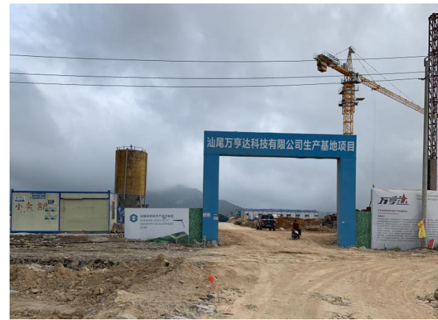
西面为万亨达在建项目
