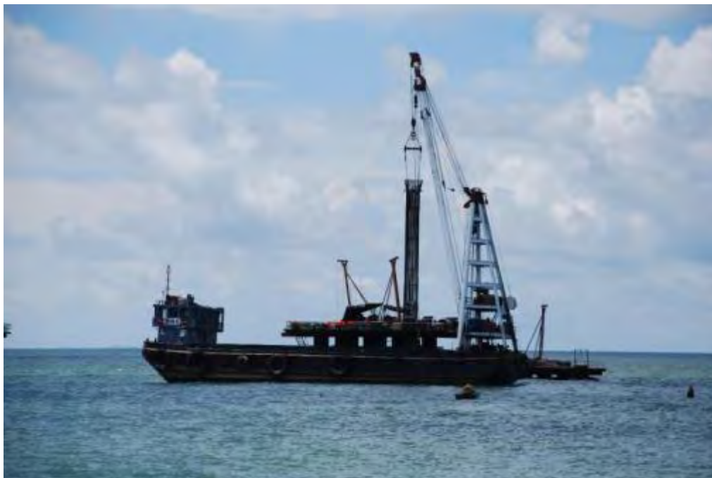
图2-34 嵌岩桩钢筋笼安放施工现场
