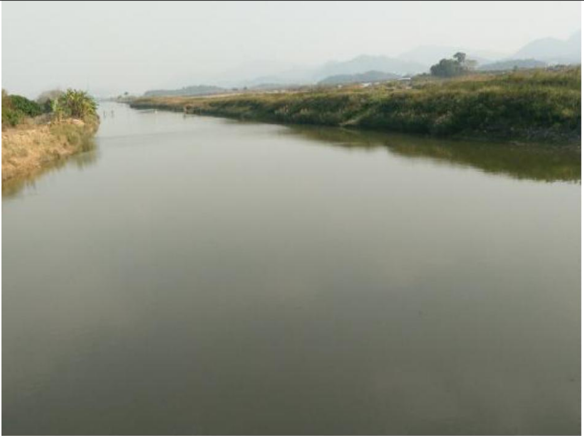
图8南西排洪渠现状图
