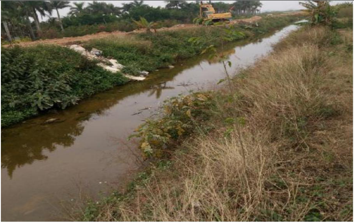
图10 洪坑排洪渠现状图
