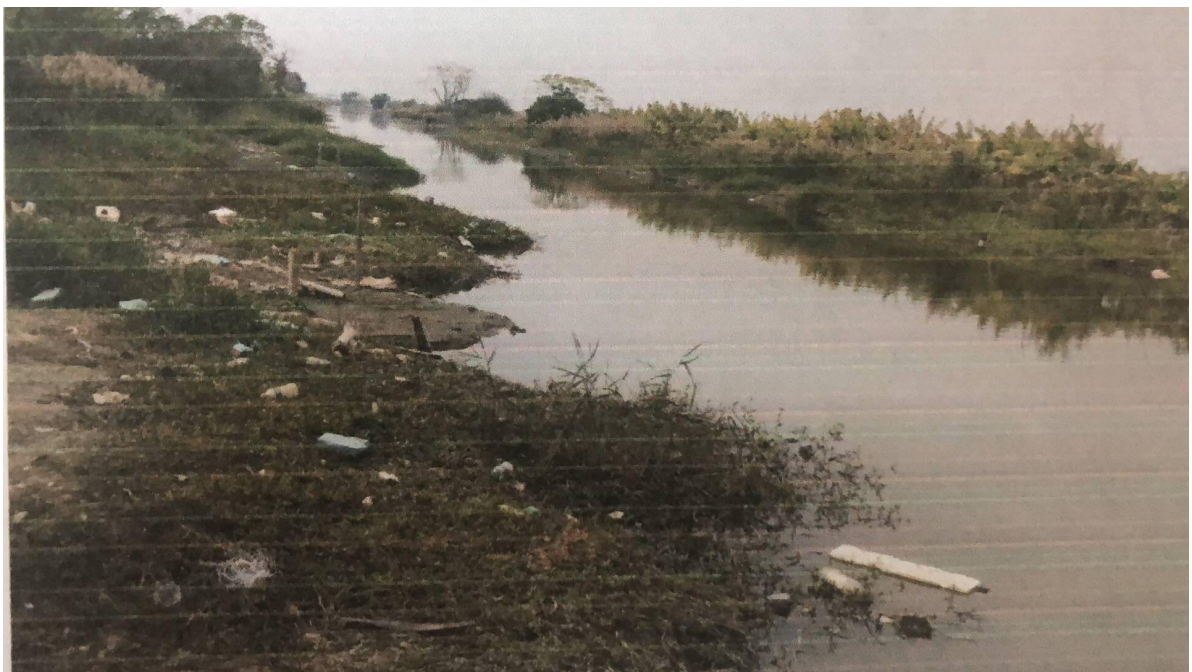
图9猫溪排洪渠现状图
