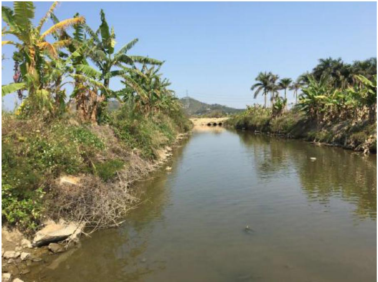
图11引西渠现状图
