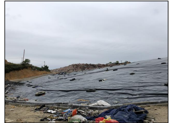
项目西面垃圾填埋场
