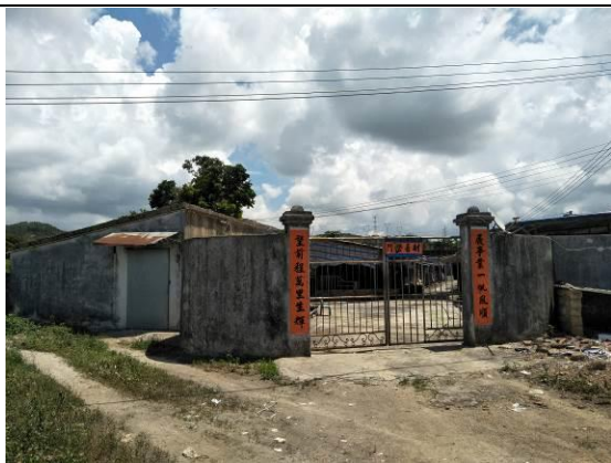
220kV 桂竹站东北侧一层养猪棚
