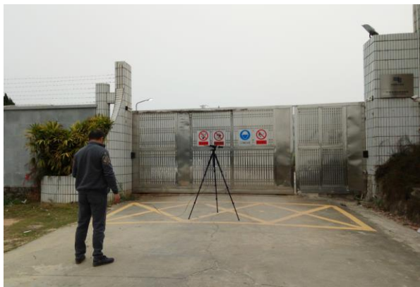
变电站大门（工频电磁场监测）
