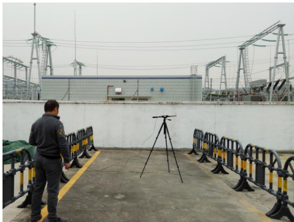
变电站围墙外（工频电磁场监测）
