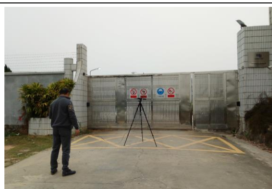
变电站西南侧大门口
