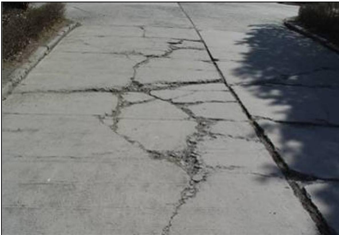
图 2.3.6-1 严重破碎板
