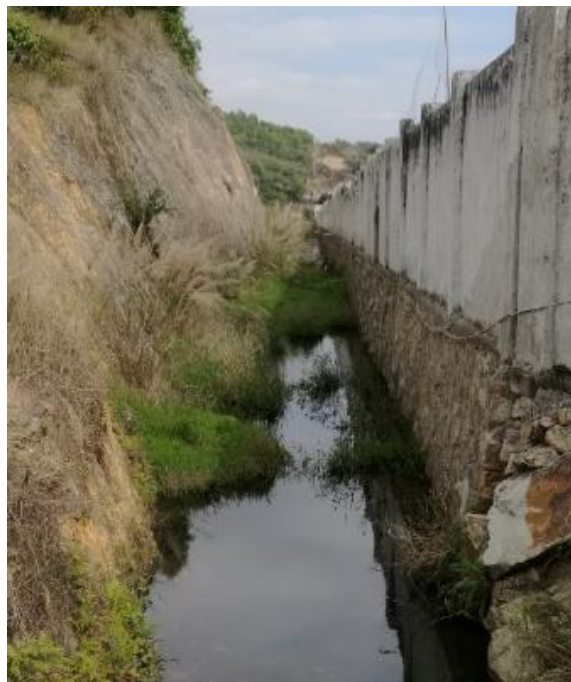
北侧道路选址跨越处排洪沟
