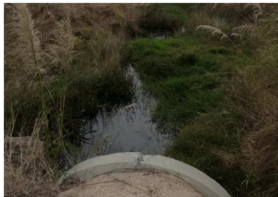
排洪渠现场照片
