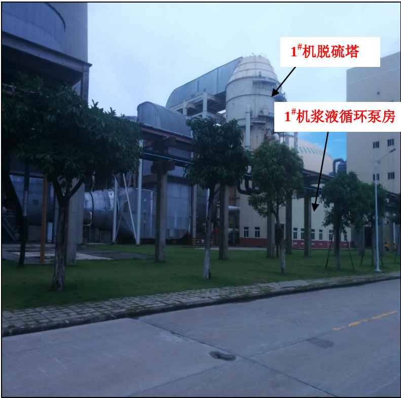
图 1-10：现有脱硫塔现场图（1#机）
