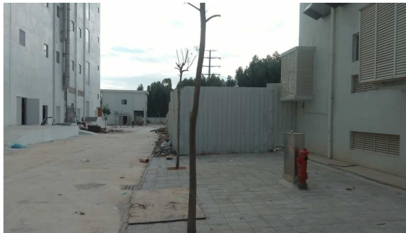
东南面 2 号污水处理站
