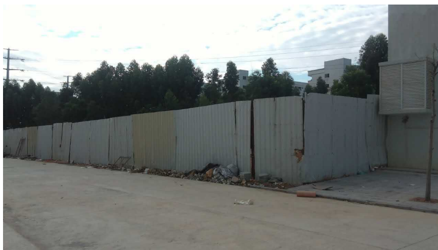
西北面汕尾 110KV 信利变电站
