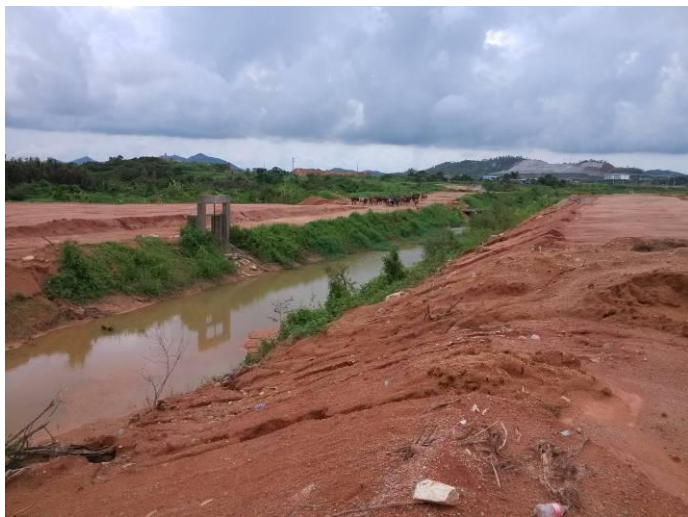
需改道原公平干渠上游，靠近火车站处
