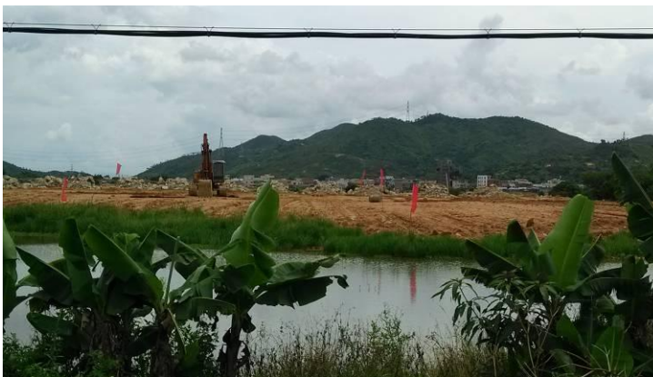
猫溪排洪渠改道（插红旗处）
