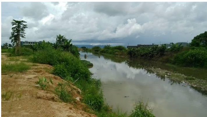
原猫溪排洪渠
