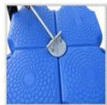
图四：用安装浮筒的专用工具转矩扳手进行安装。
