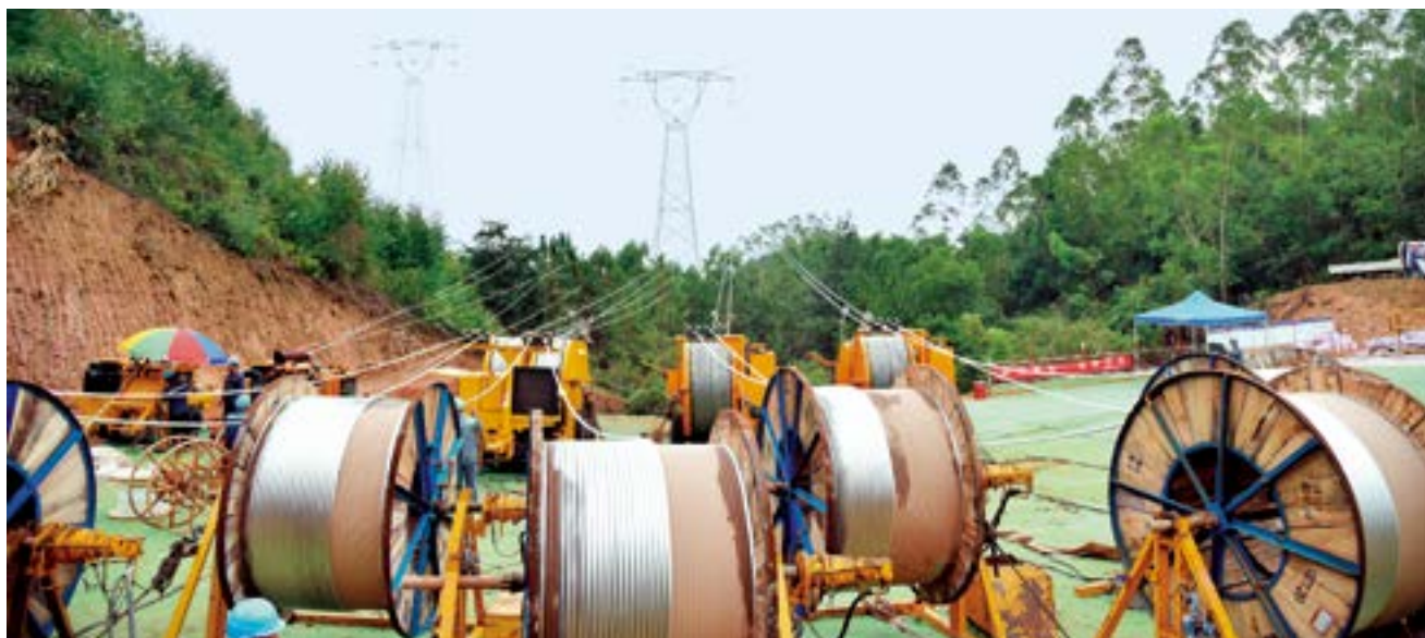
2022年11月5日，南方电网公司首次在500千伏输电线路实现了八分裂导线技术工艺的新突破。图为广东电网重点项目——粤港澳大湾区500千伏外环东段（汕尾段）工程顺利完成了该“八分裂”导线展放技术的首秀
