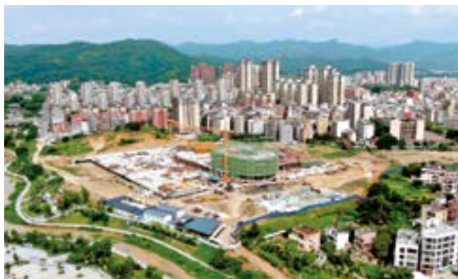
建设中的新时代公园
