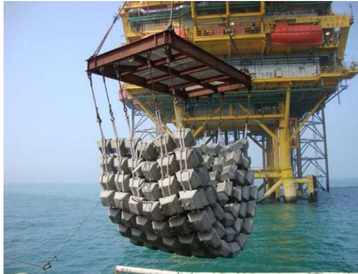
图 2.3.1-9 水泥压块保护示意
