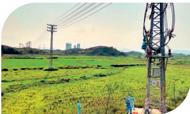
2020年4月20日，汕尾供电局工作人员为辖区线路，安装自动化用户分界开关，进一步保护线路安全稳定运行，确保不受用户故障影响
