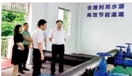
海丰县联安镇大液河提水泵站建成，解决6800亩农田灌溉需求
