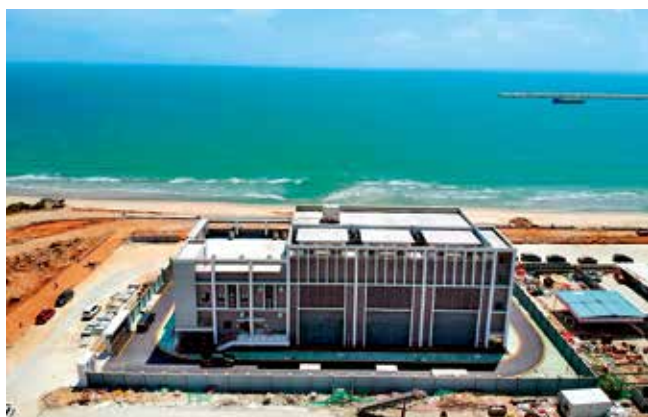
2021年9月17日，110千伏观海输变电工程竣工投产。该工程新建110千伏变电站一座，新增主变压器2台，新增容量12.6万千伏，新建线路44.9千米，助力陆丰西部地区配网供电能力
