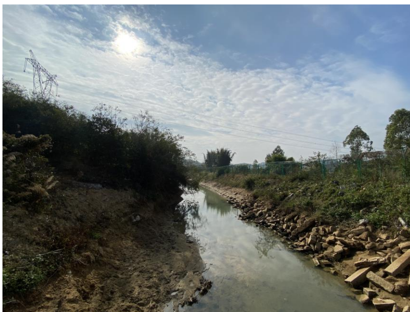
图 3.2-8 本工程拟建线路跨越公平灌渠
