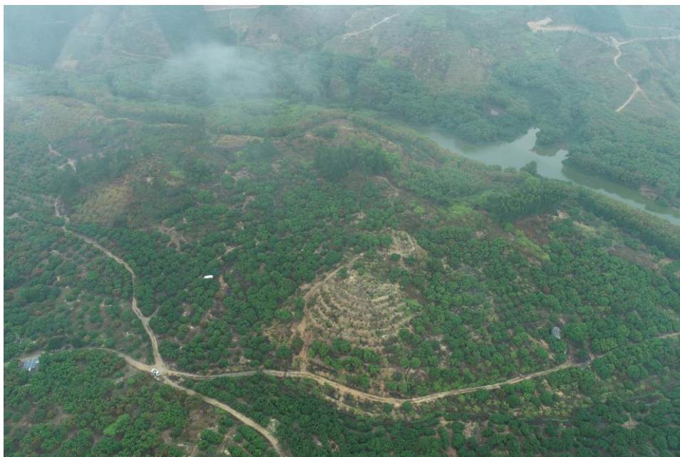
图 3.2-1 500kV 陆丰变电站现状
