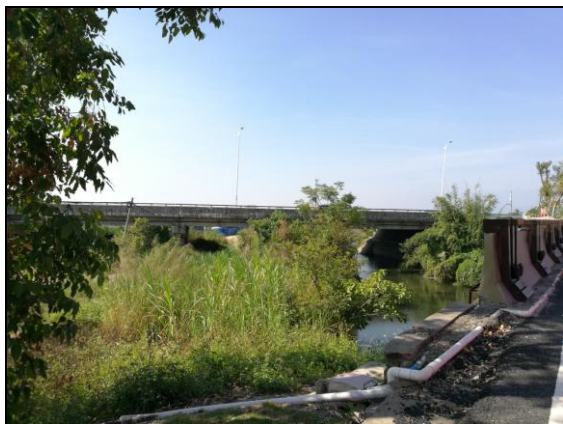
现状黄江大桥 E115.34825, N22.85711
