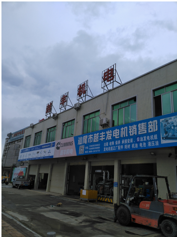
项目西面越丰机电
