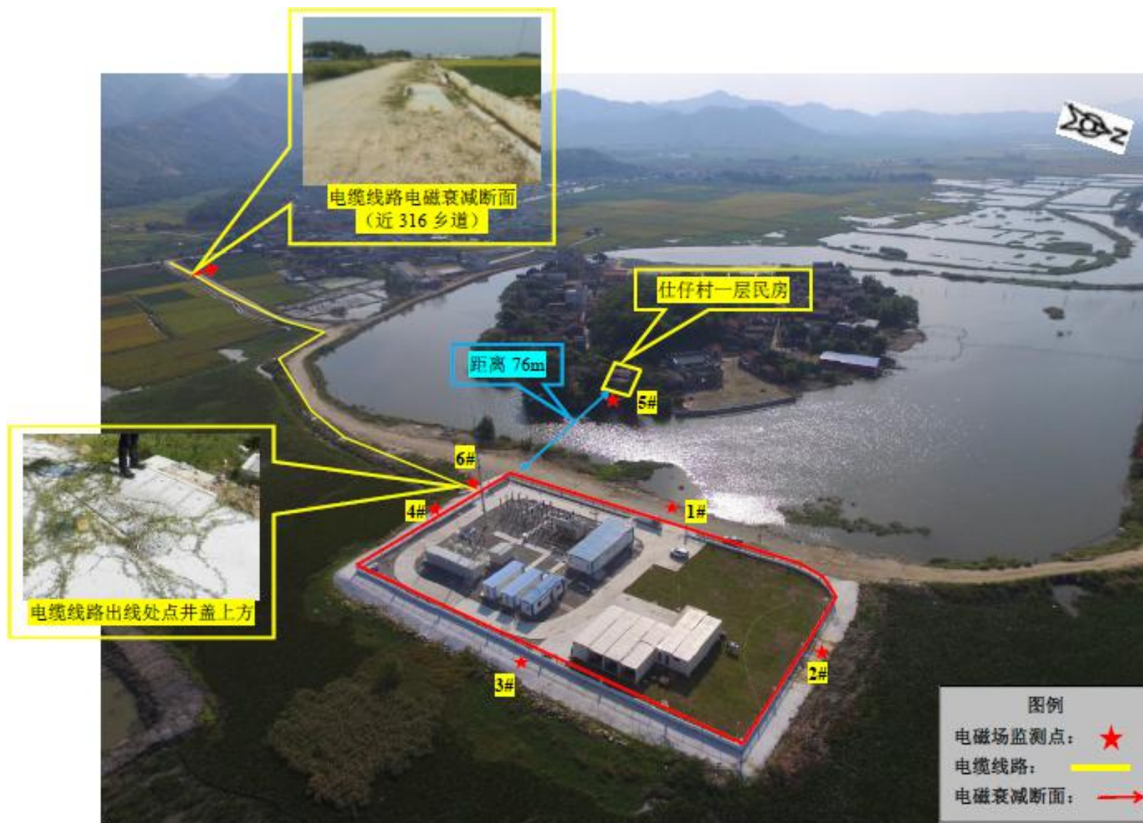
图 7-1 升压站四周及新建电缆线路电磁监测点位示图
