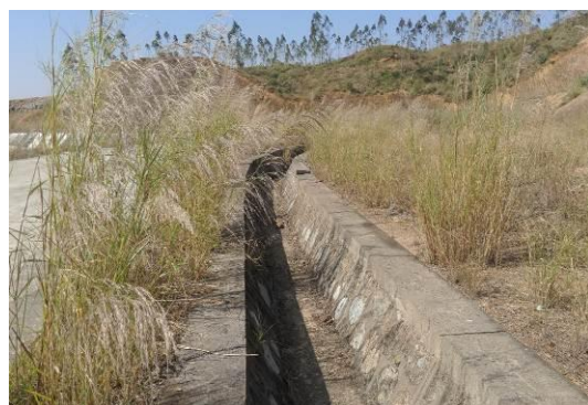
照片 3-14 填埋场北面截洪沟
