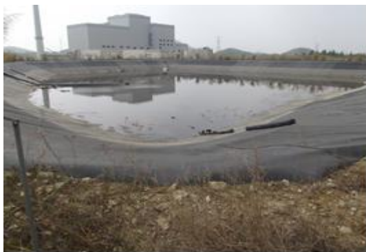
照片 3-9 渗滤液调节池
