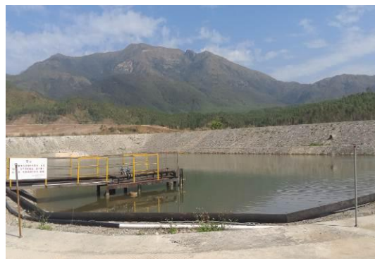
照片 3-10 地表水沉淀池
