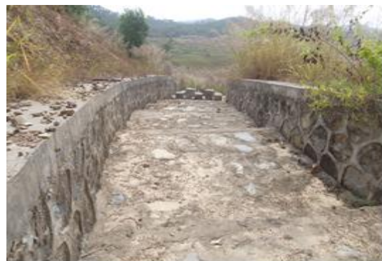
照片 3-6 排洪出水口
