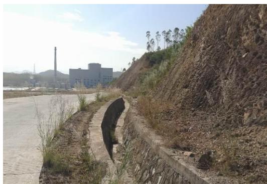
照片 3-13 填埋场西面截洪沟
