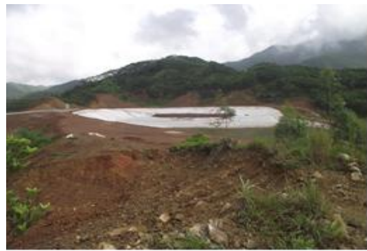
照片 3-2 建设情况
