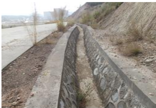
照片 3-5 已建排洪沟
