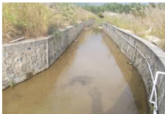
照片 3-8 新建排水明渠进水
