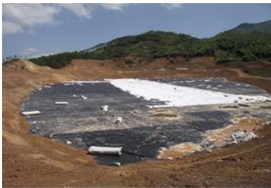
照片 3-1 建设情况
