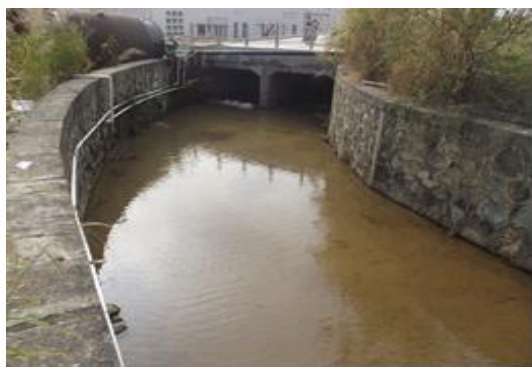
照片 3-7 新建排水暗渠进水
