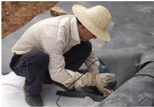
照片 3-3 热熔焊接 PE 管防渗膜
