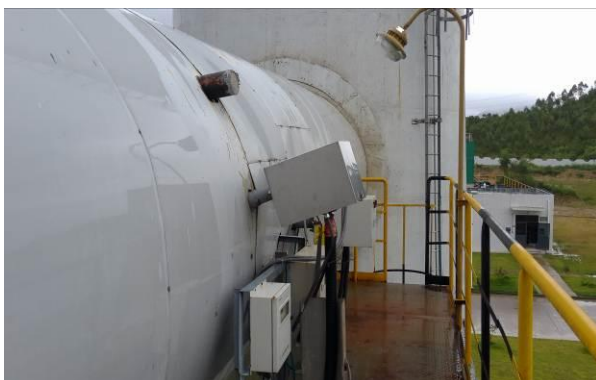
照片 6-4 监测操作平台
