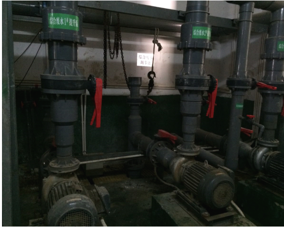
照片 1 综合废水取水口
