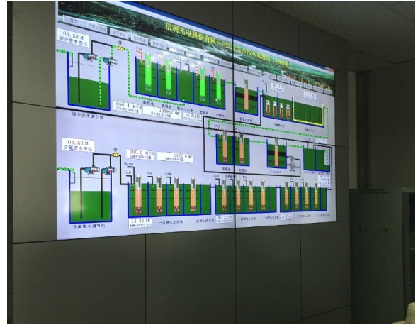
照片 2 废水处理设施监控系统
