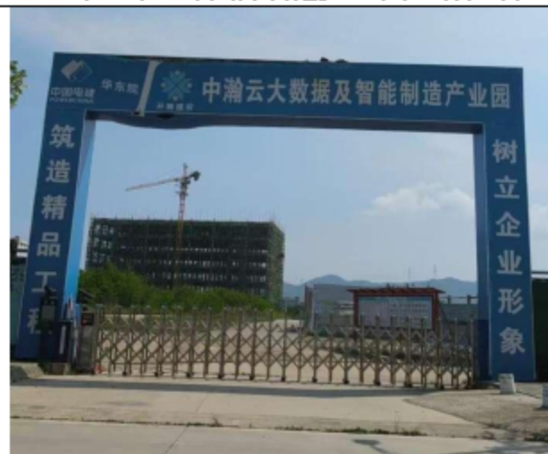
西侧—中瀚云大数据及智能制造产业园（在建）
