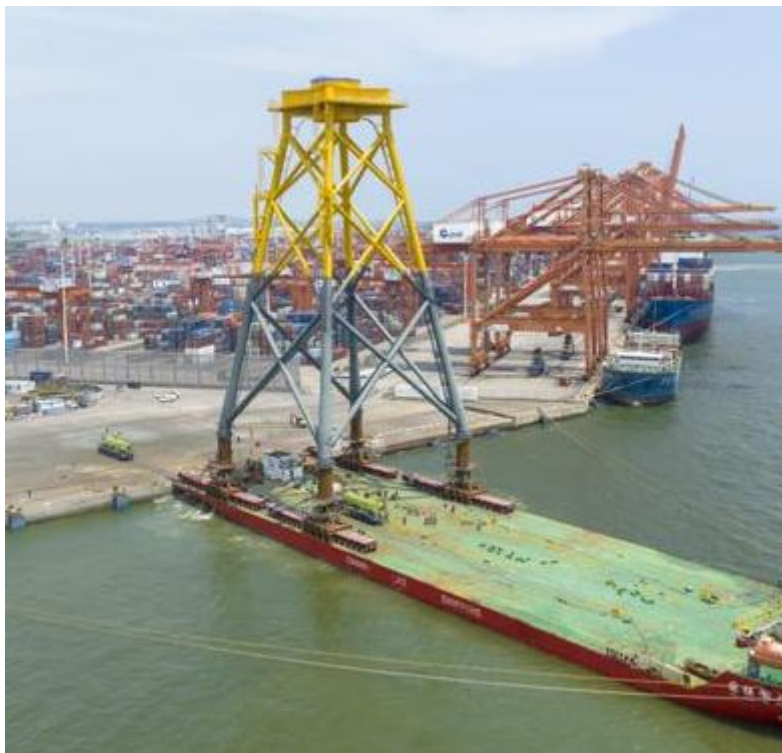
图 2.2-8 导管架滚装上船图
