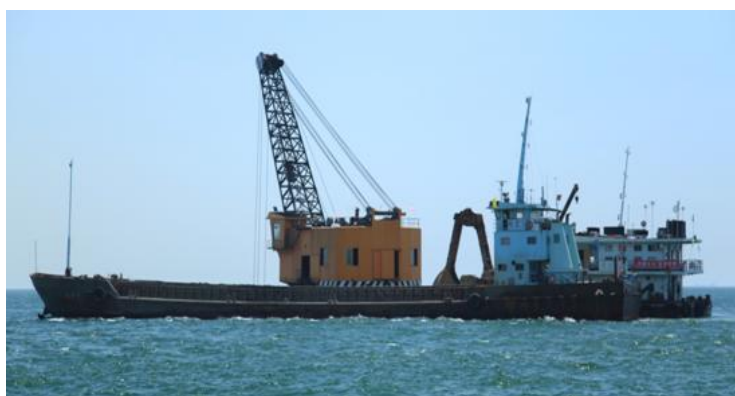
图 2.3-5 抓斗船挖泥施工图
