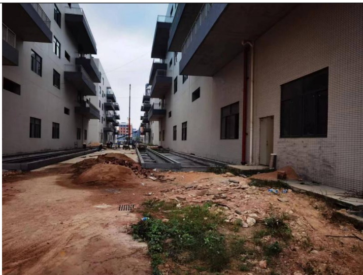
项目南面环境照片
