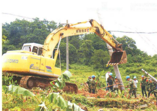
图为台风“天兔”抢修现场。
