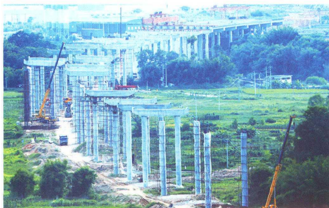
建设中的潮惠高速公路陆河段榕江特大桥
