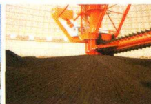
堆取料机正在卸煤
