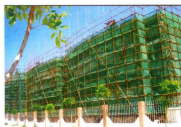
建设中的生活区
