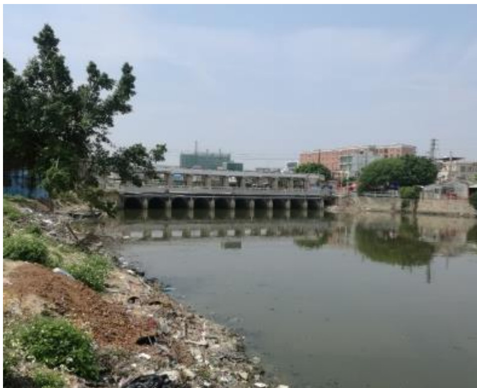
图 4.3.2-3 碣石水闸现状图
