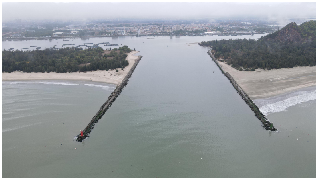
图 2.1.2-6b 现状东西拦沙堤现状图（南向北视角）
