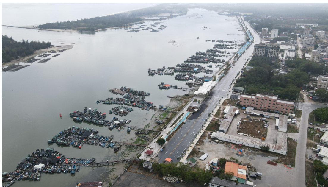
图 2.1.2-3 简易浮排码头现状照片
