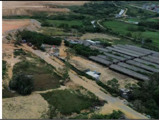
变电站西南侧区域
