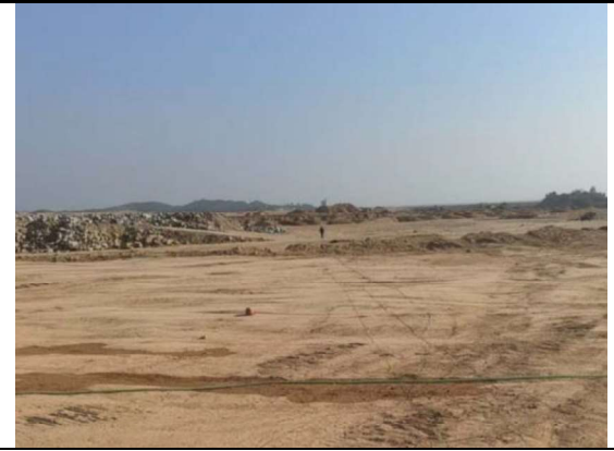
变电站西北侧区域
