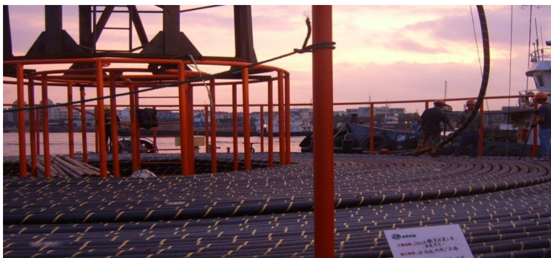
图 3.1.6-5 海缆散装过缆示意二
