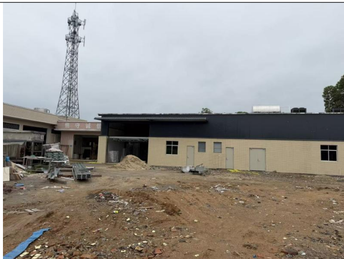
项目厂区现状及保留建筑
