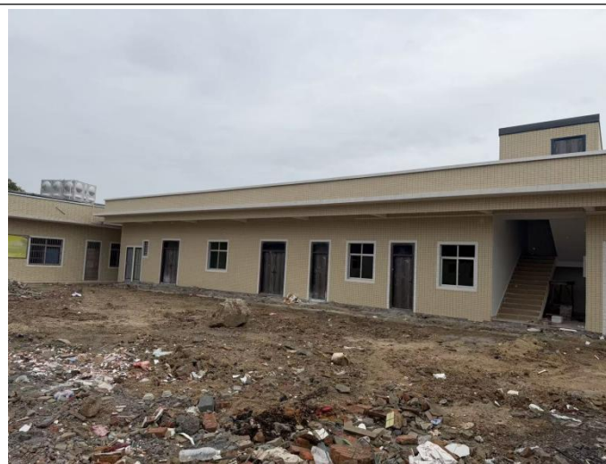
项目厂区现状及保留建筑
