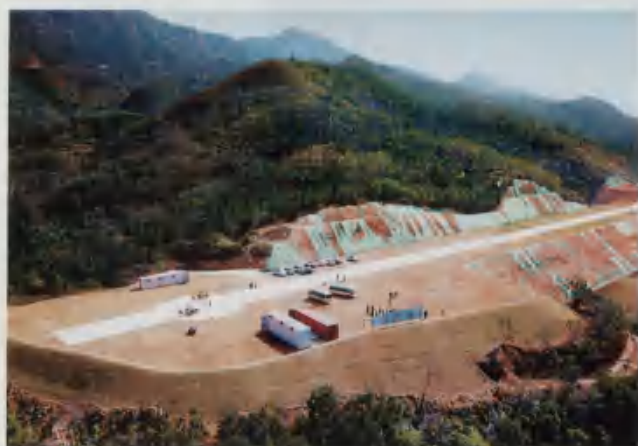
河口航空运动田园综合体项目机场跑道
