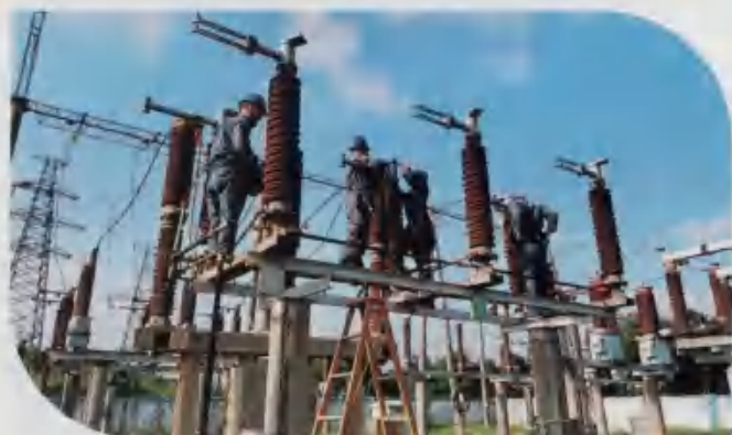
2020年9月21日，汕尾供电局开展110千伏甲子变电站两处刀闸接线板检修项目
