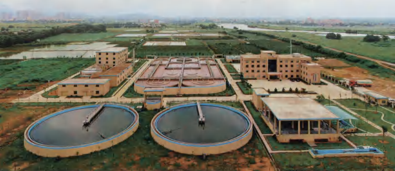
海丰县城第二污水处理厂
