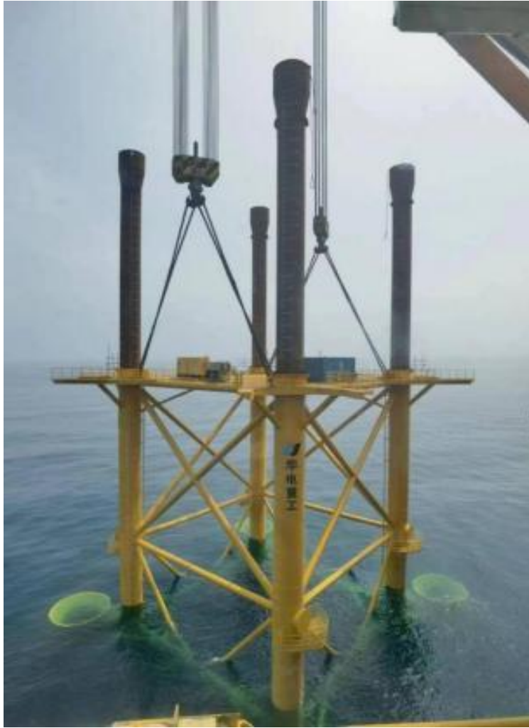
图 1.6.1-1 定位架安装
