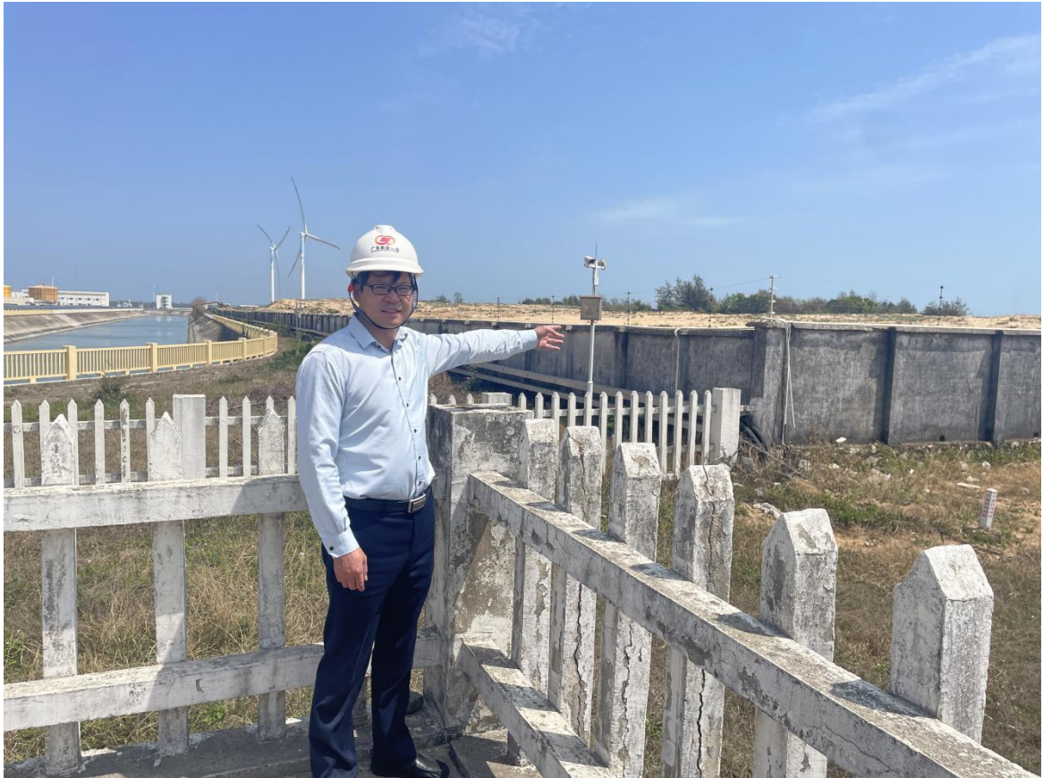
产品气 CO 2 输送管道（电厂东侧厂界）
