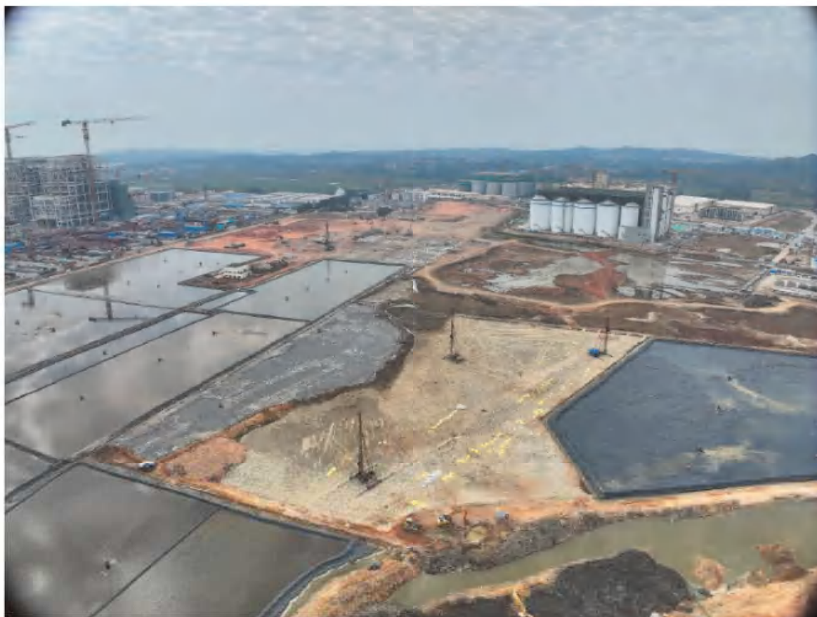
图 6.11.3-3 项目现状航拍图
