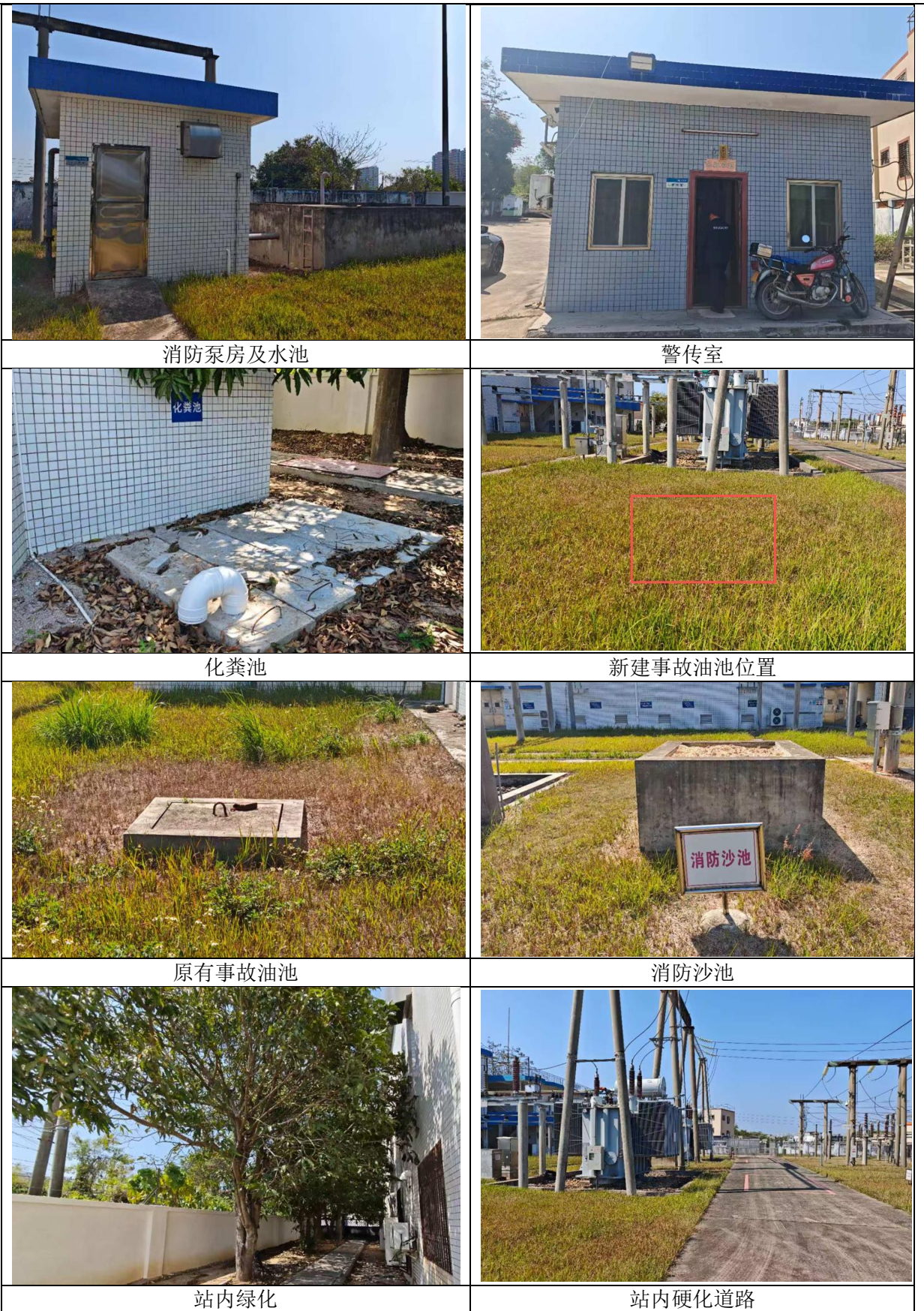
图 2-5 110 千伏甲子变电站站内现状照片
