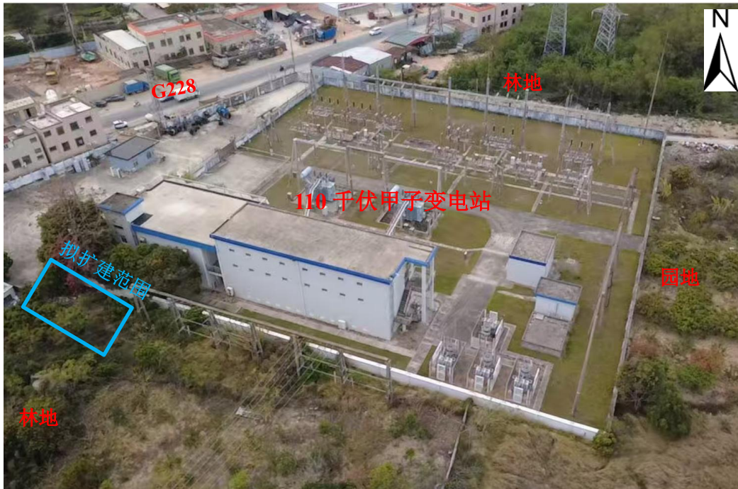
图 2-1 变电站站址现状图
