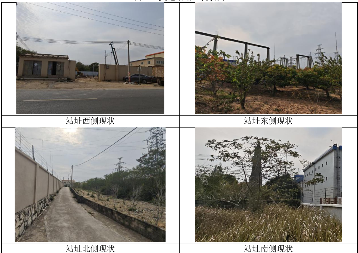
图2-2 变电站四周现状图
