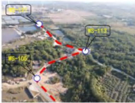
照片 7: 节点 WS-100~WS-121 石鼓山景区 段 (顶管施工)
