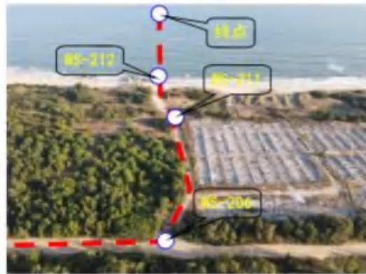
照片 12: 节点 WS-205~WS-212Y013 乡道至终点 段 (WS-205~WS-211 开挖施工, WS-211~WS-212 顶管施工、WS-212~终点沉管施工)
