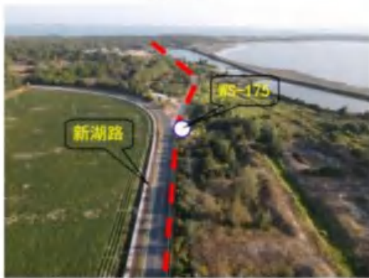
照片 11: 节点 WS-167~WS-205 新湖路至 Y013 乡路段 (开挖施工)
