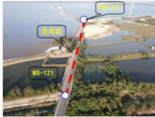
照片 8: 节点 WS-121~WS-131 连岛路段 (开挖施工)
