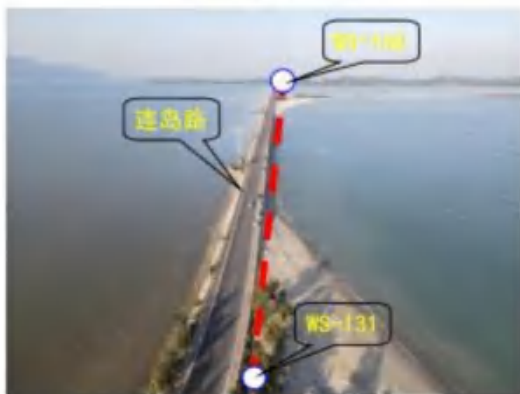
照片 9: 节点 WS-131~WS-160 连岛路堤段 (架管施工)
