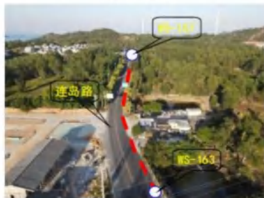
照片 10: 节点 WS-160~WS-167 连岛路至新 湖路段 (开挖施工)
