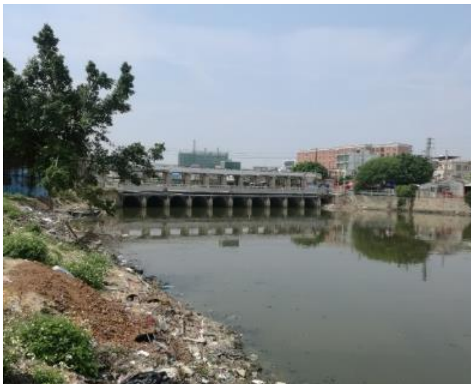
图 4.3.2-3 碣石水闸现状图
