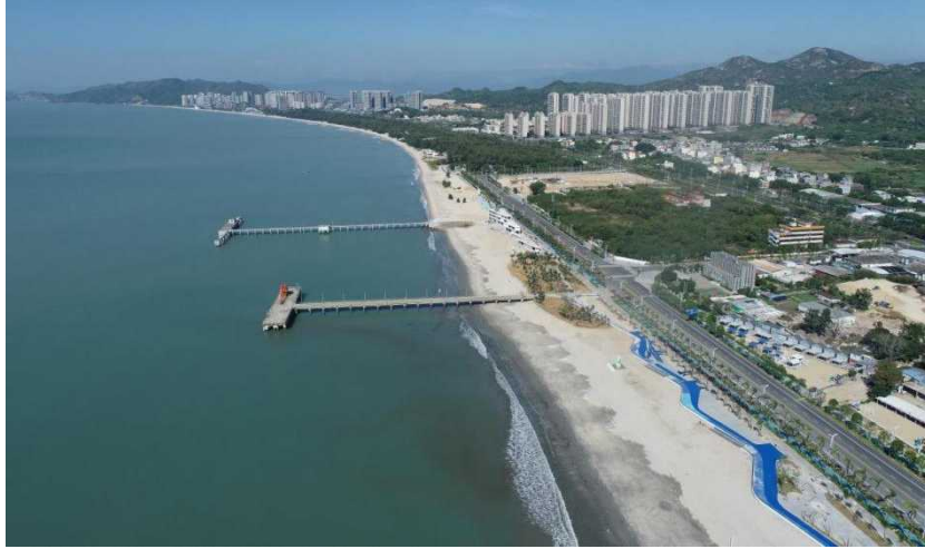
图 6.2-7 广东省航道支持保障系统工程汕尾航道管理码头工程现状照片
