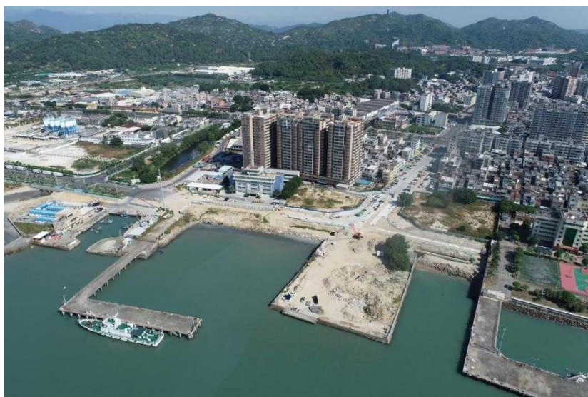
图 6.2-6 汕尾海事局工作船码头填海工程现状照片
