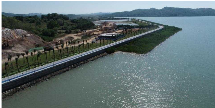
图 6.2-8 汕尾市市区防洪（潮）续建工程现状照片
