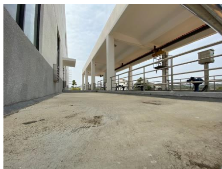
赤沙水厂取水口
