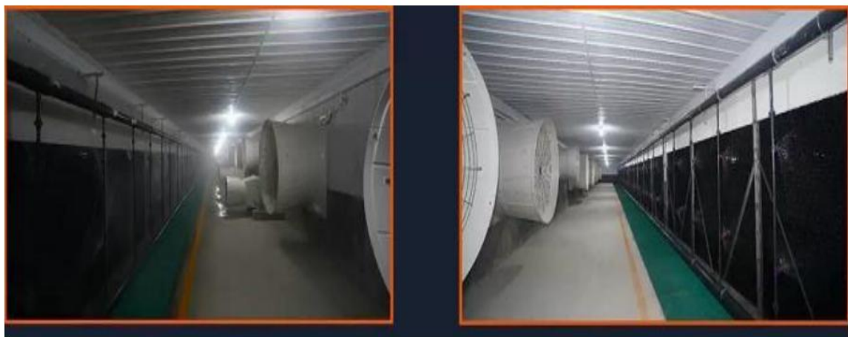
图 8.2-2 猪舍除臭风机及生物除臭水帘图（同类型项目实景图）
