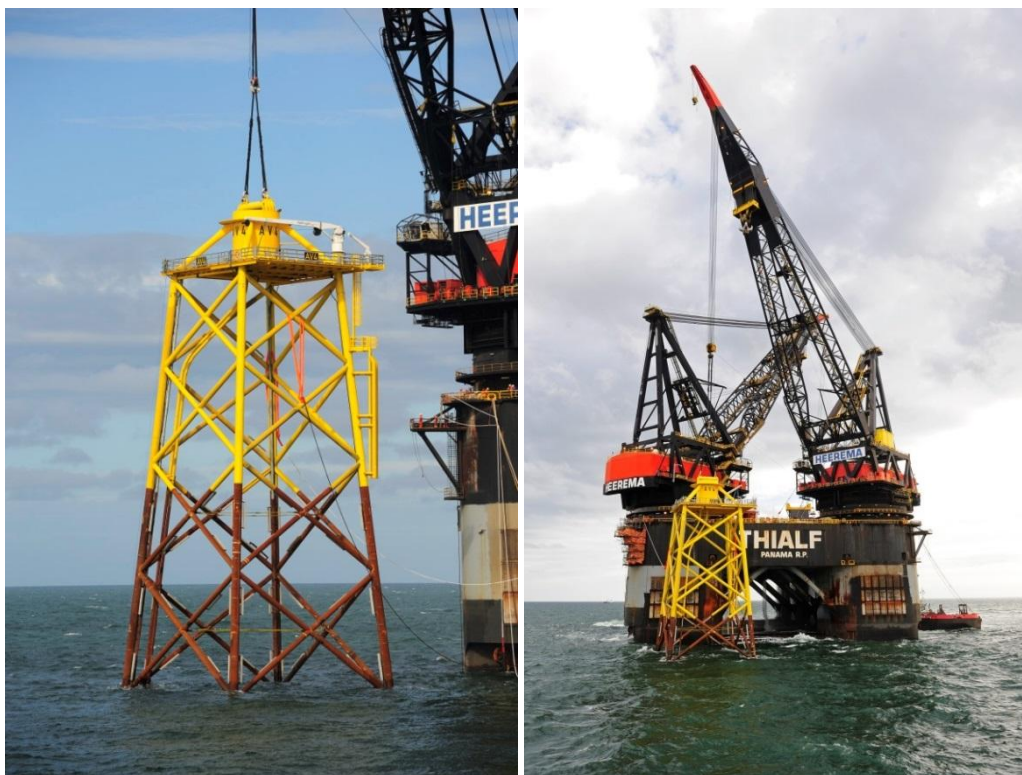
图 2.3.5-1 导管架切割之前准备工作示意图
