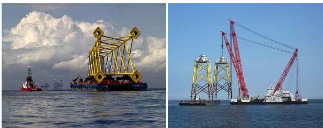
图 2.3.5-3 导管架运输示意图
