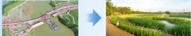
文翰湖公园通过“工程措施+生态措施”，融入大量海绵元素。北侧公园调蓄湖通过内河涌和节制闸与橹尾撬水道相连通，周边地块雨水就近汇入水系，兼具滞纳、调蓄、净化雨水功能，缓解区域排涝压力。
