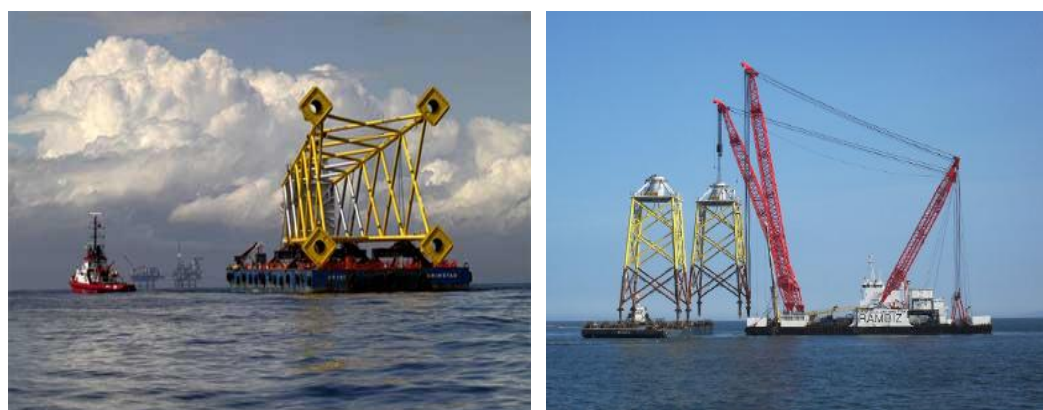
图 2.3.5-3 导管架运输示意图
