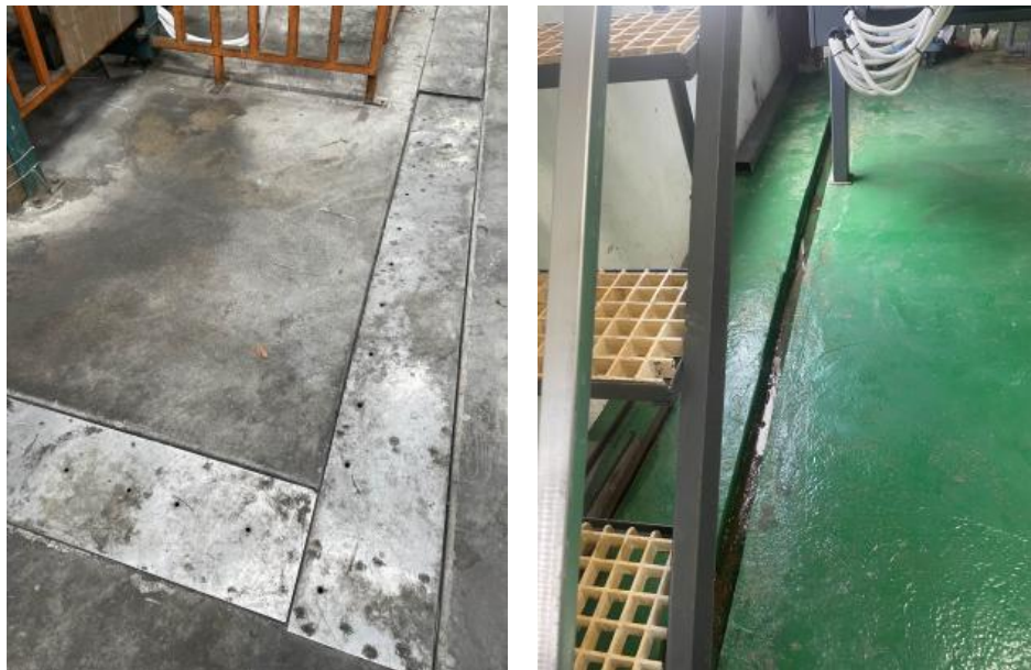
图 4-8 清洗线防泄漏措施照片
